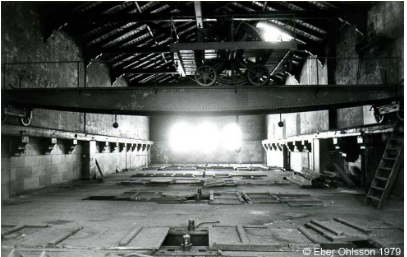
Fig 3:12. Köpenhamn 1979. Vattenverket. Övre maskinsal.
