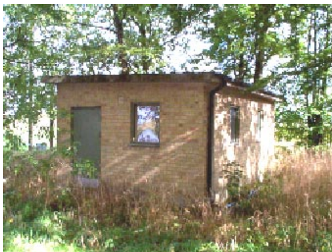
Maskinbyggnad med högtryckspumpar.
