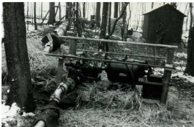
Provisorisk pumpning, februari 1947.
