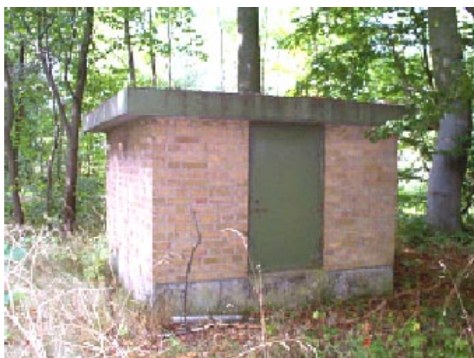
Borra med brunnsöverbyggnad.
