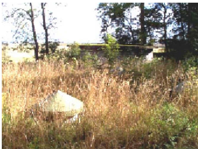
Lågreservoar under vegetationen samt luftningsbyggnad.
