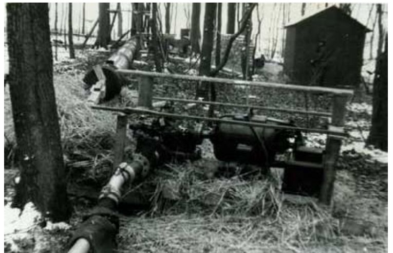
Provisorisk pumpning , februari 1947.
