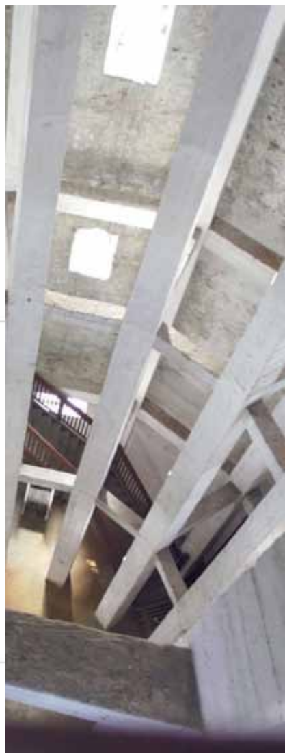
Interiörbild från tornet. Notera trappan som ringlar sig upp vid ytterväggen.
