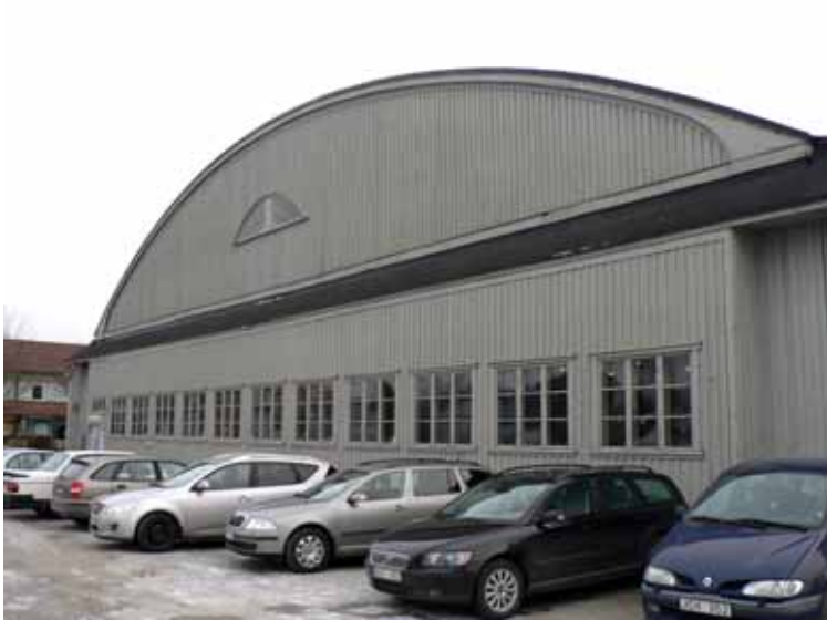
8. Hangar 2, västra gaveln.
