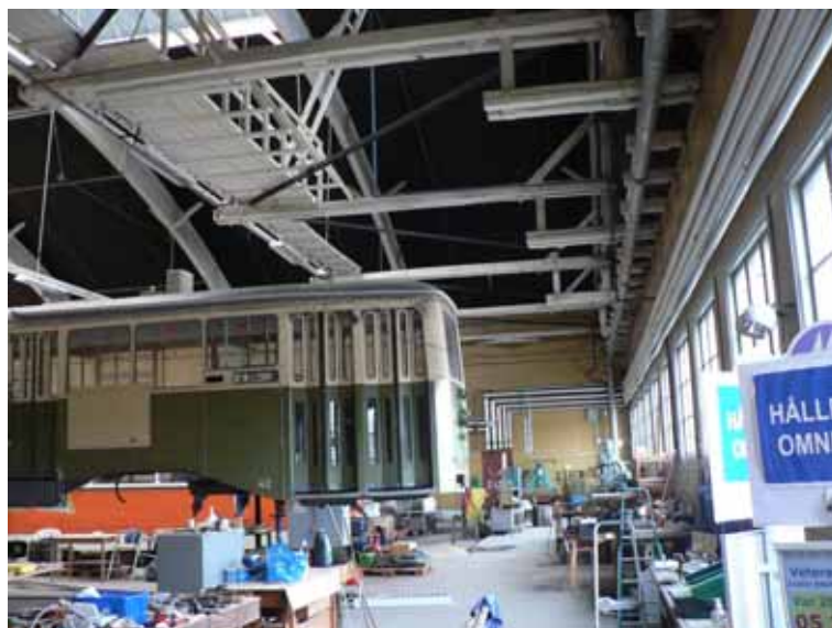
12. Hangar 2, interiör. Vy söderut utmed västra gaveln.
