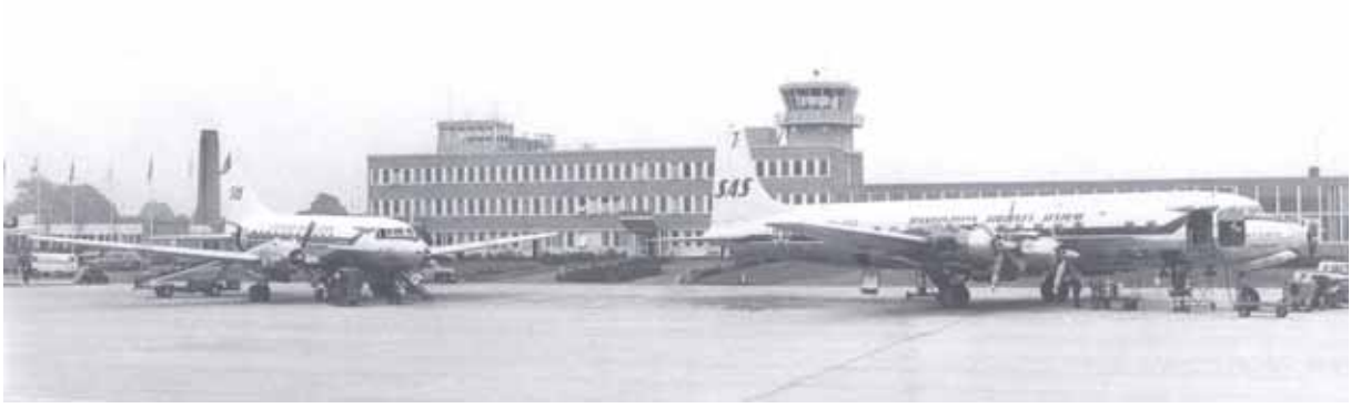
24. 1959-års terminal. 1957-59 uppfördes en ny terminal. Den bestod av en uppglasad avgångshall samt en kontorsbyggnad i tre våningar med trafikledartorn och meteorologisk station på taket. Kontorsbyggnaden var i gult tegel och inrymde administration, tull, trafikledning och meteorologiavdelning. Avgångshallen är rivet, medan kontorsbyggnaden finns bevarad och rymmer idag byggvaruhuset Optimera. Den tekniska utrustningen från flygledartornet finns bevarad och utställd på Malmö Museer, Teknikens och sjöfartens hus.
