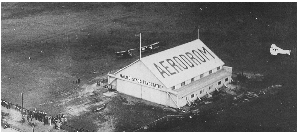
1. Flygbild över Bulltofta med Hangar 1, sommaren 1924. Hangar 1 uppfördes till öppningen av flygplatsen 1923. Den var i korrugerad plåt och flyttades till Bulltofta från Landskrona, där den tillhört Thulins flygplansfabrik. När F10 etablerades i norra delen av Bulltofta flygfält under andra världskriget flyttades Hangar 1 dit och användes som marketenteri. Hangaren revs 1969.
