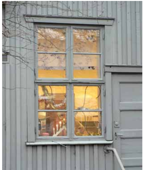
6. Hangar 2, fönster norra fasaden
