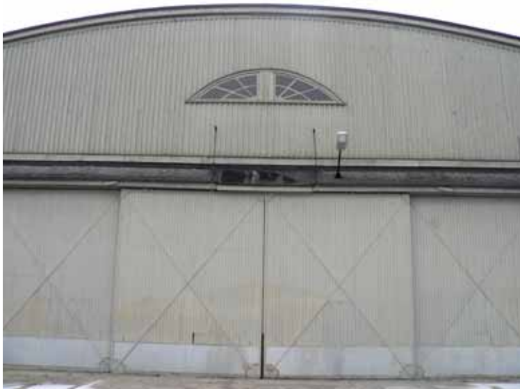
4. Hangar 2, detalj, östra fasaden.
