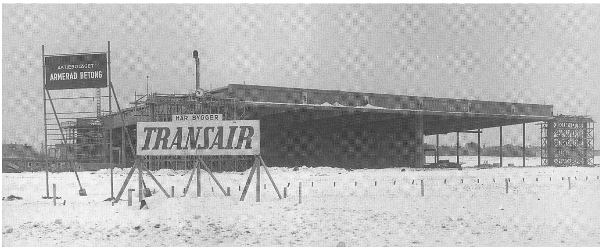
22. Transairs hangar under uppbyggnad, cirka 1962.
