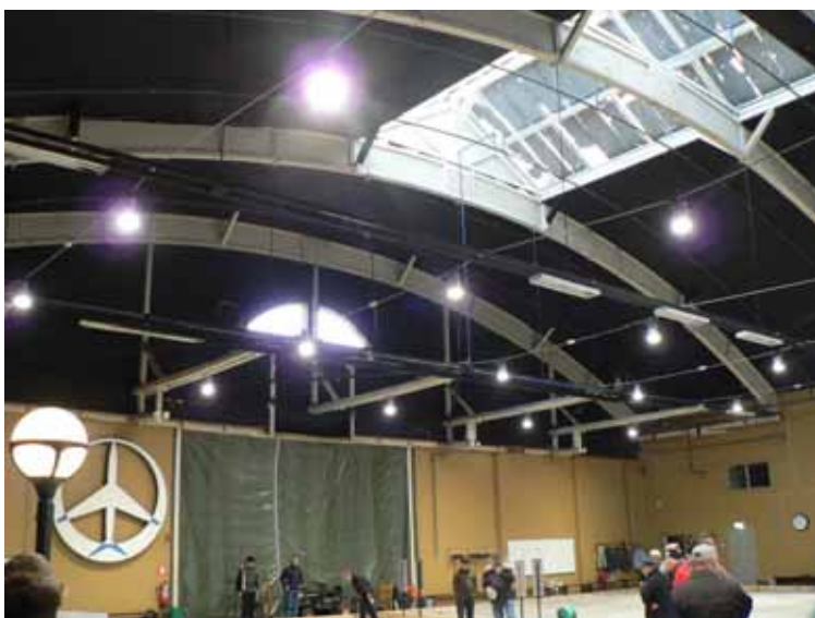
13. Hangar 2,,interiör, östra delen.
