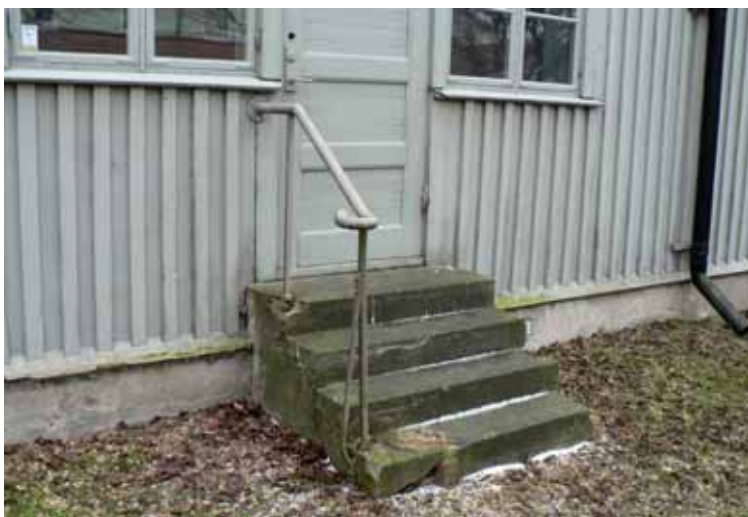
7. Hangar 2, trappa och dörr norra fasaden.
