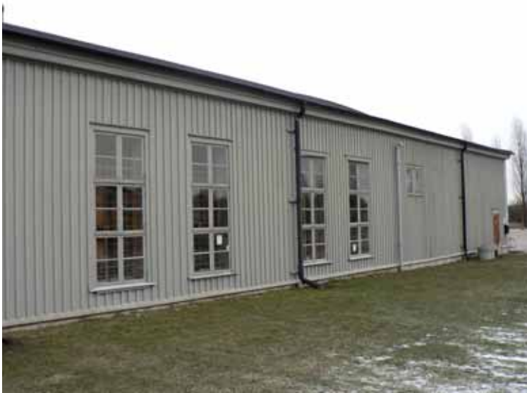
9. Hangar 2, södra fasaden.
