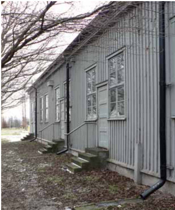
5. Hangar 2, norra fasaden.
