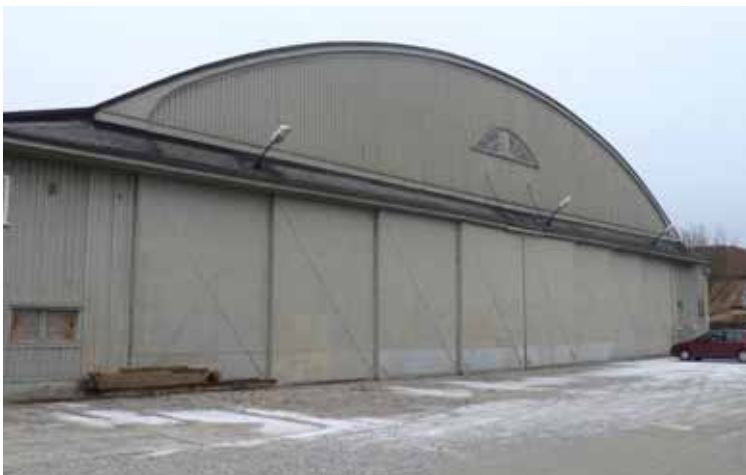
3. Hangar 2, östra fasaden.
