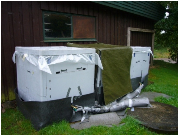
Figur 5. En vanlig modell av en növvattentank. Här är tanken inkopplad till ett hushålls vanliga vattenledningssystem.
