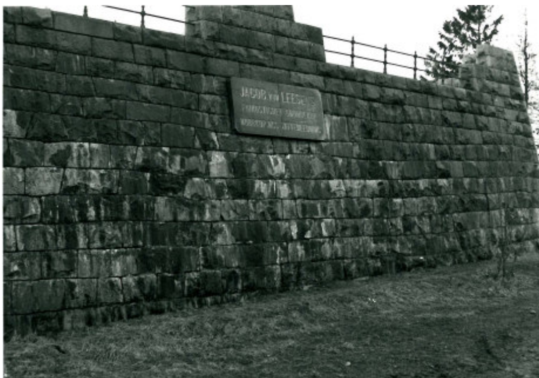
Bild 15. Norrköpings vattenreservoar under rivning.
