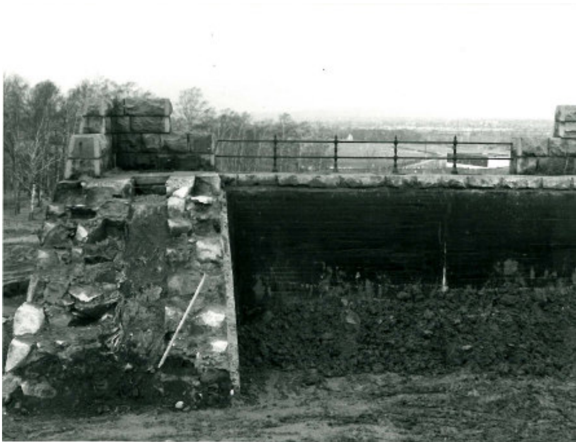
Bild 13. Norrköpings vattenreservoar under rivning.
