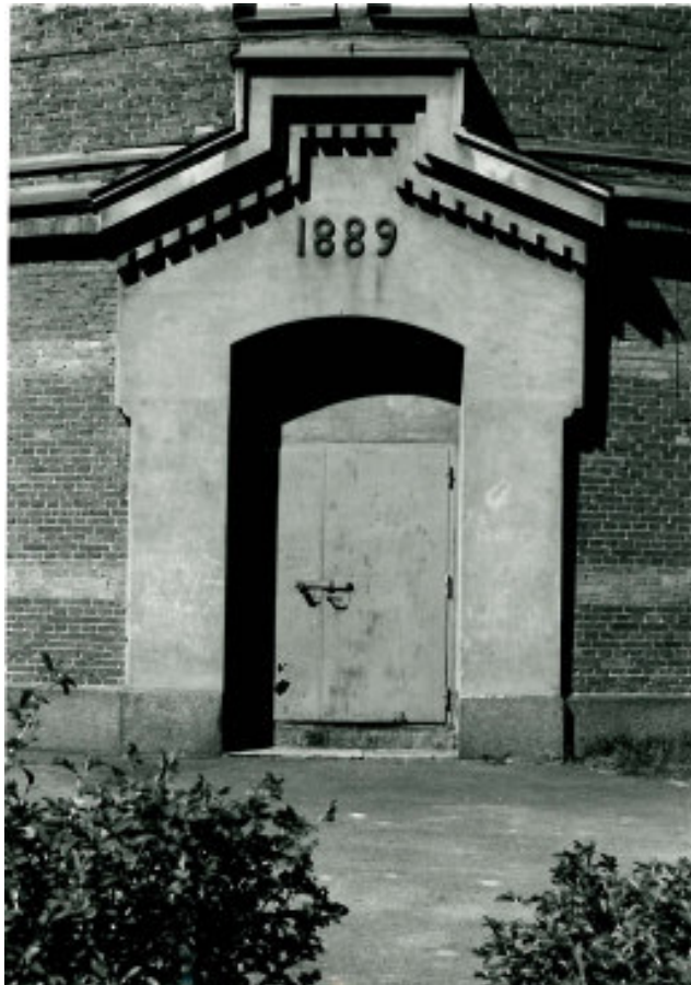
Bild 30. Portalen till Karlstads vattentorn.
