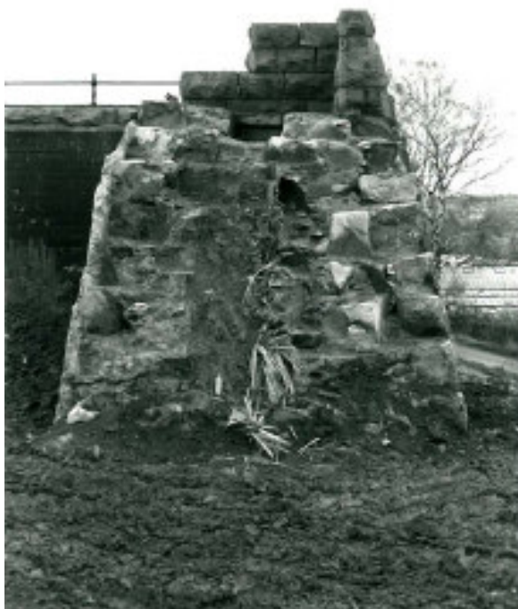
Bild 1. Vattenreservoaren i Norrköping under rivning.
