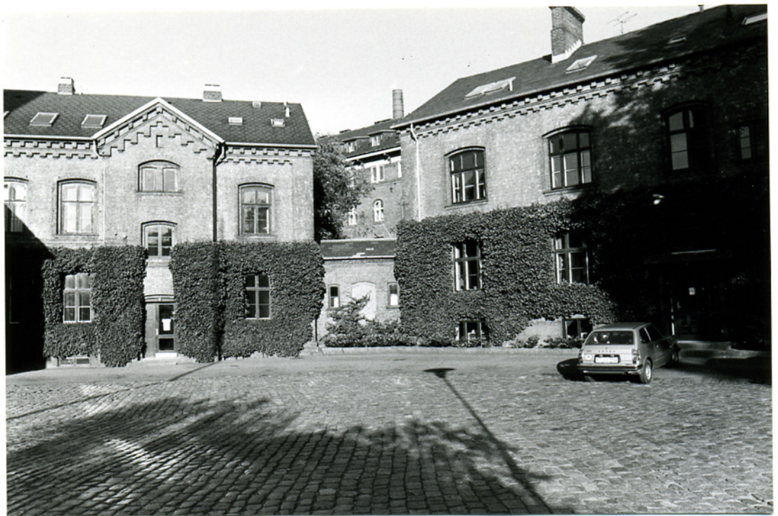
Fig 3:12. Köpenhamn 1979. Vattenverket. Byggnader från 1859 resp 1900.
