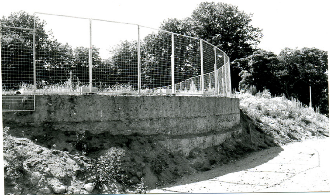
Fig 1:10. Helsingborg 1979. Vattentornets grundmur.
