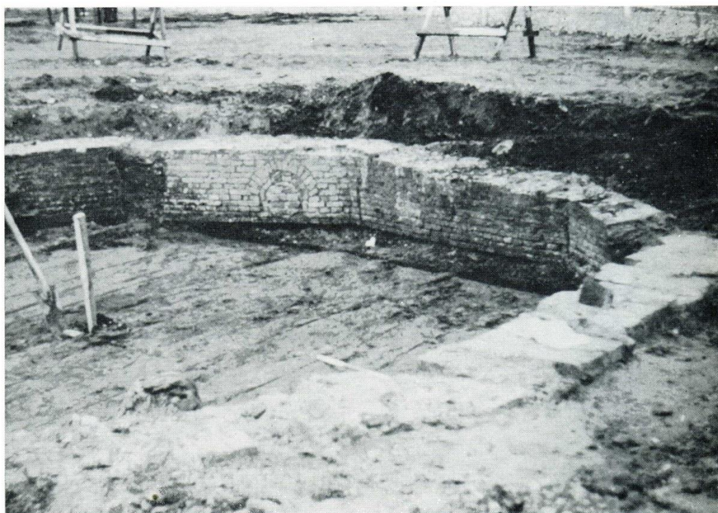
Fig. 4. Från utgrävningen av "Vattenkonsten".
