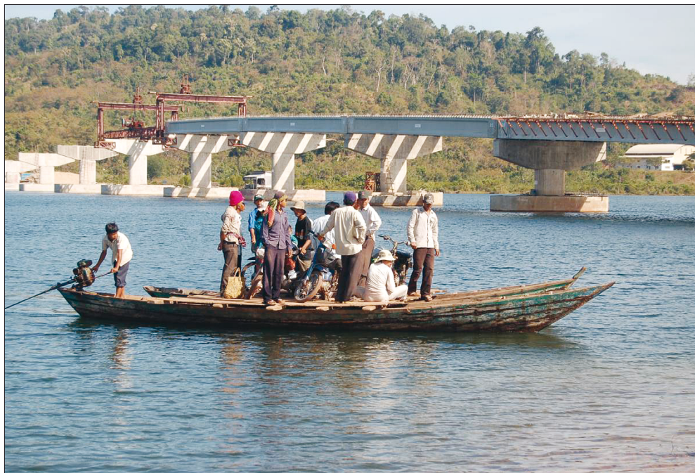
Figur 5. En av fem mindre floder som måste passeras mellan Sihanoukville och thailändska Trat-provinsen. Brobyggen är på gång i stora delar av landet. Foto: Johan Käberg, jan 2007.
