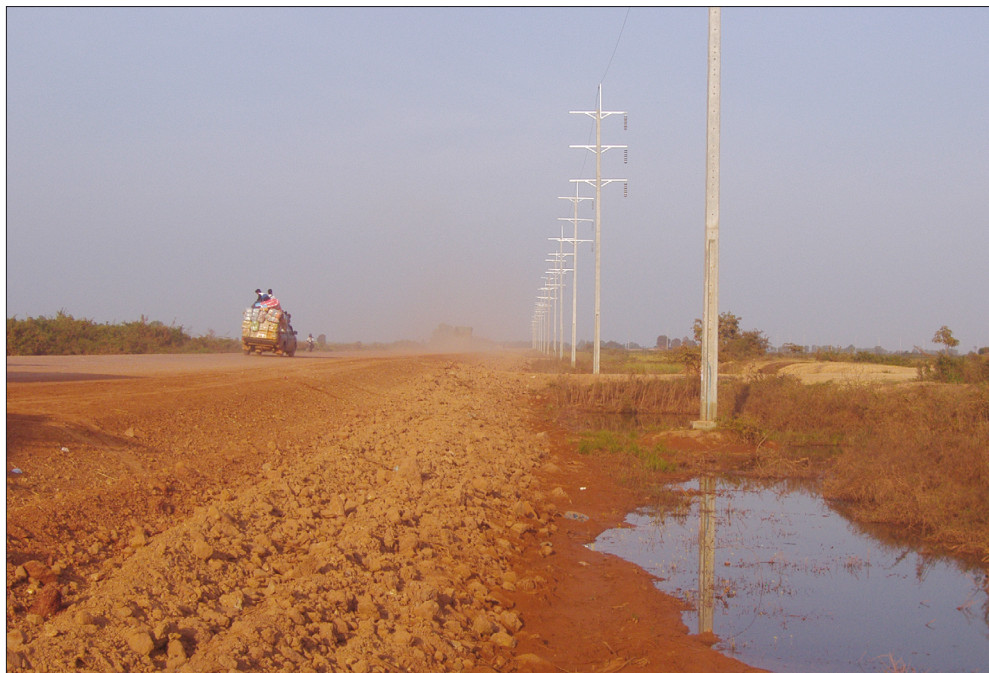
Figur 2. Ännu ej asfalterad väg med nyligen uppförda betongstolpar för elektricitet. Ledningarna är ännu ej på plats. Foto: Johan Kåberg, dec 2006.
