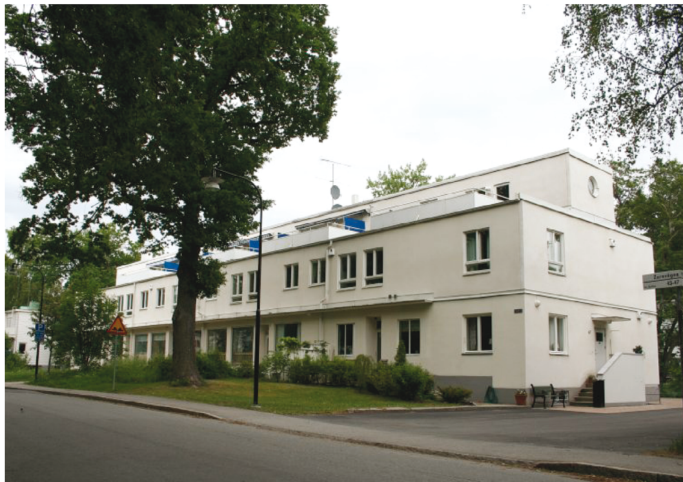
Figur 3. Servicelängan vid Zornvägen i Södra Ängby efter ombyggnaden. Foto: Mats Olsson.
