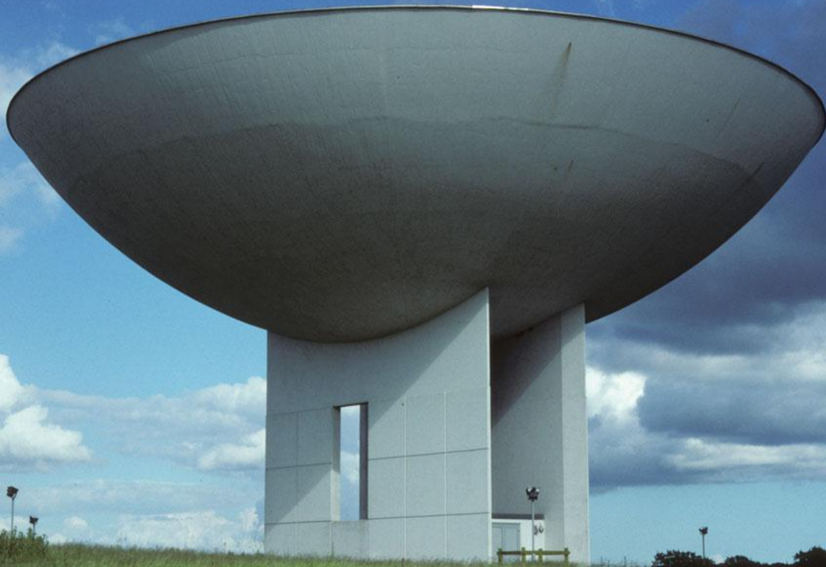
Enkla former kan ge vackra vattentorn. Arkitekt Wolfgang Kleemann. Haderslev i Danmark, 1992.
